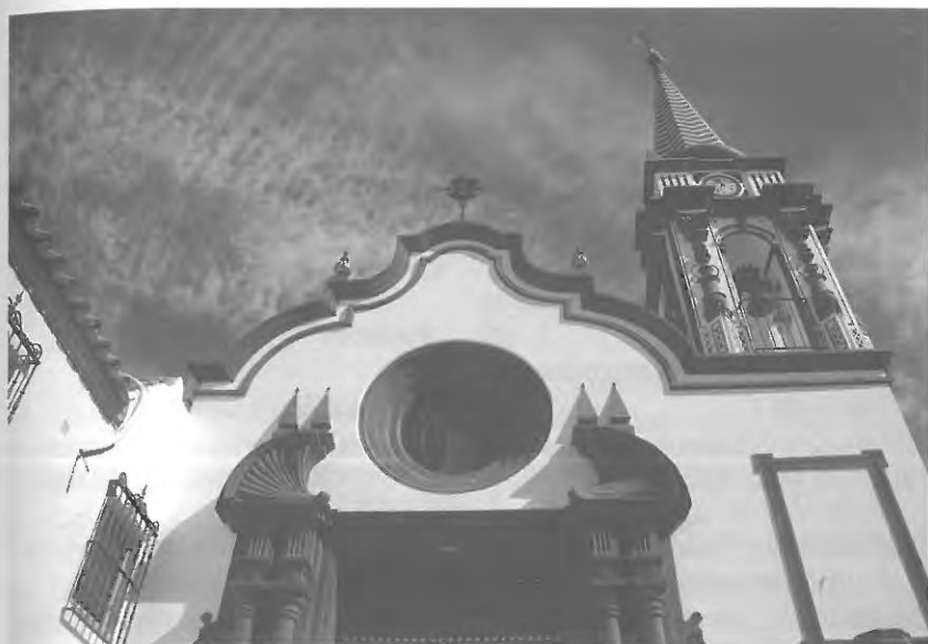
Fachada Iglesia actual
